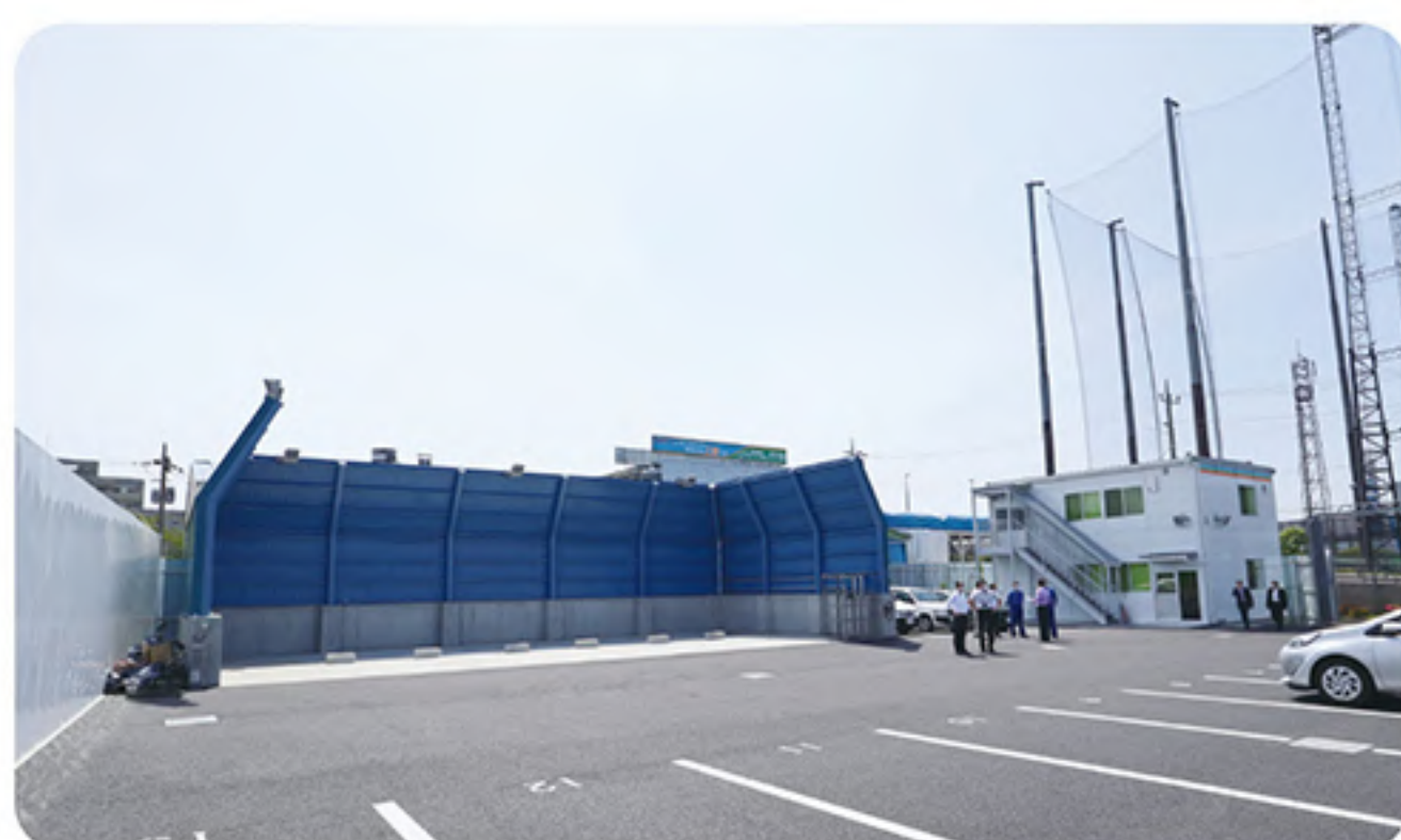
正面に洗車場、右奥に事務所があります
