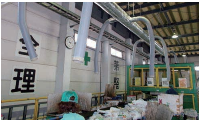
手選別ライン上には冷風を送るスポットクーラー
