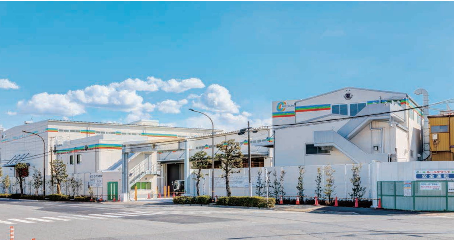
予定通りに工事を終え、装い新たに工場を稼働しています
