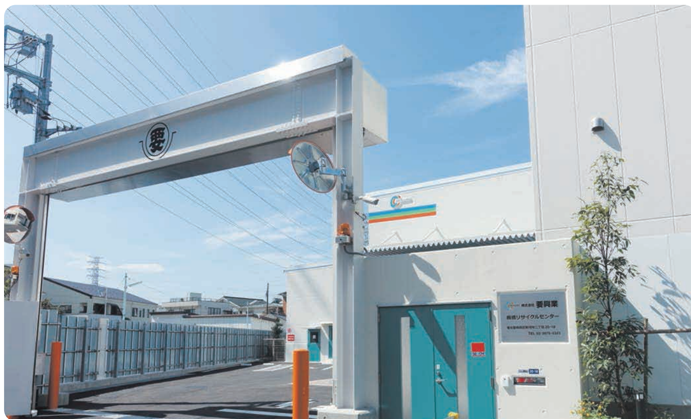
板橋リサイクルセンター。不燃ごみの扱いに特化したリサイクルセンターです
