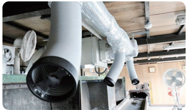
ガラスびんの選別ラインに設置したスポットクーラー
