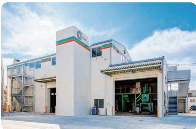
2階建てのB棟。今後、様々な事業に活用していきます
