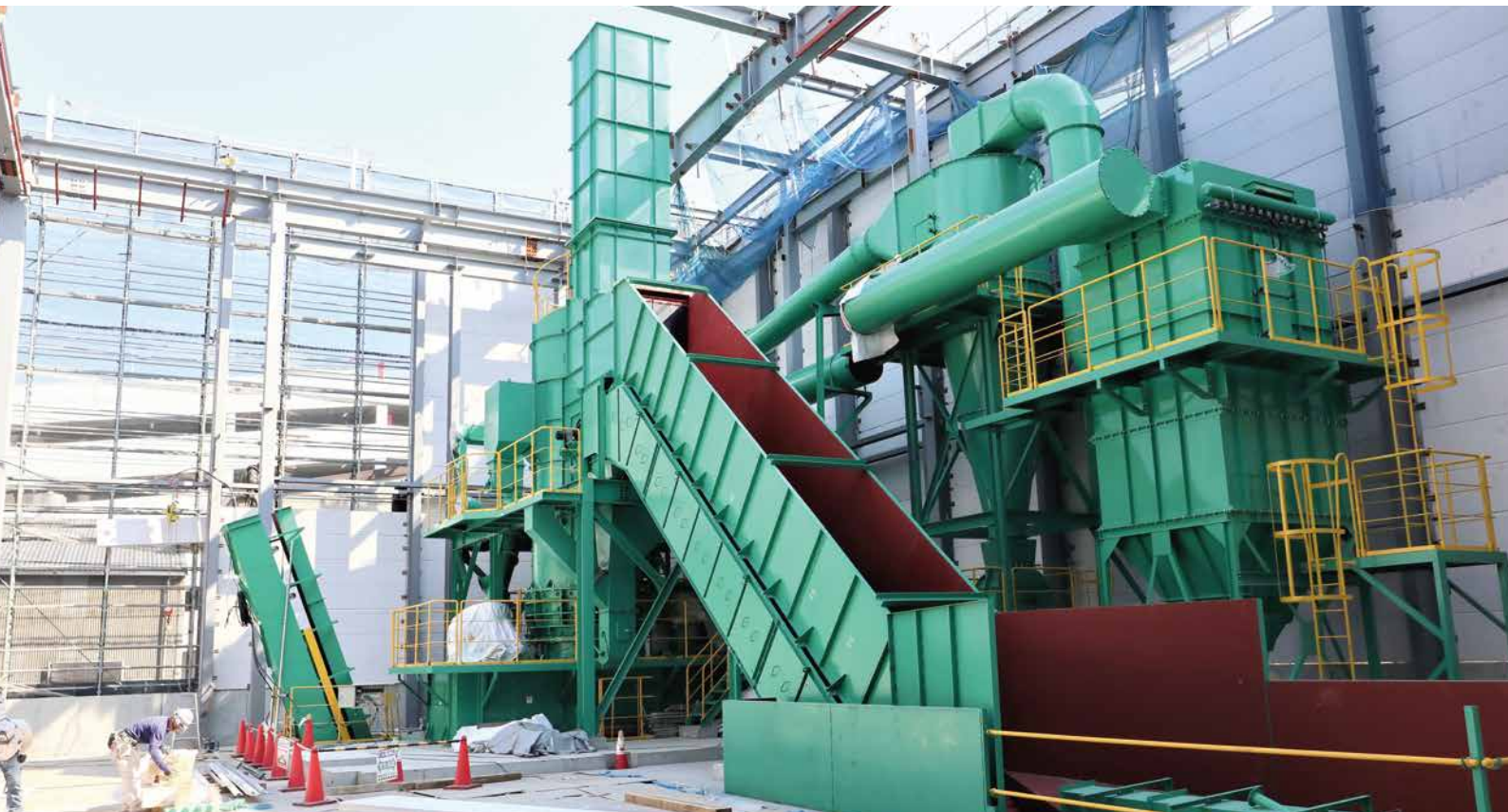
建設中のプラント。民間の施設としては東京23区最大級の粗大ゴミ処理施設になる予定です
