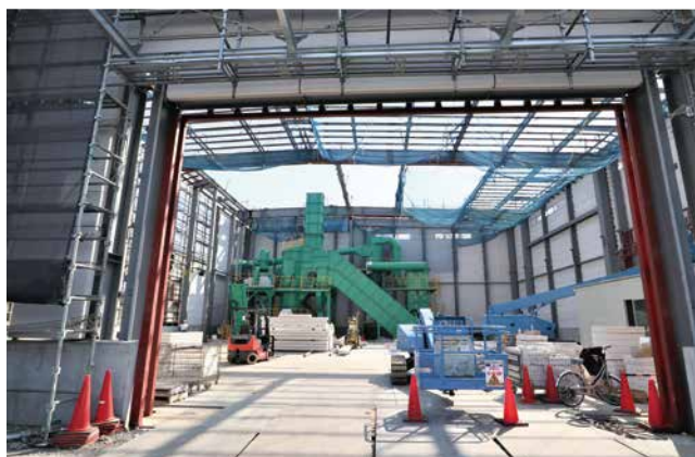
粗大ごみ処理施設建設工事の様子
