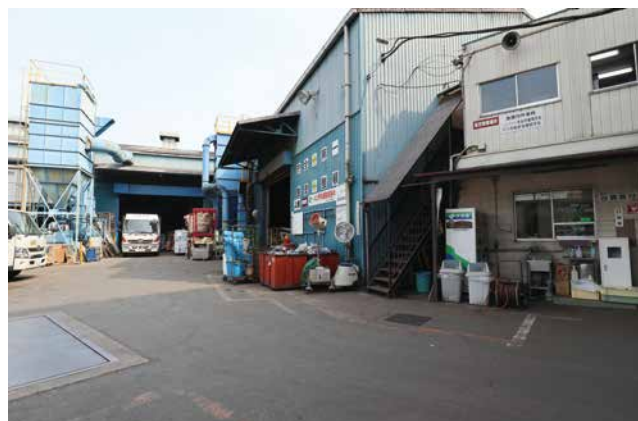
現在の鹿浜工場。 写真奥に新プラントを建設中です
